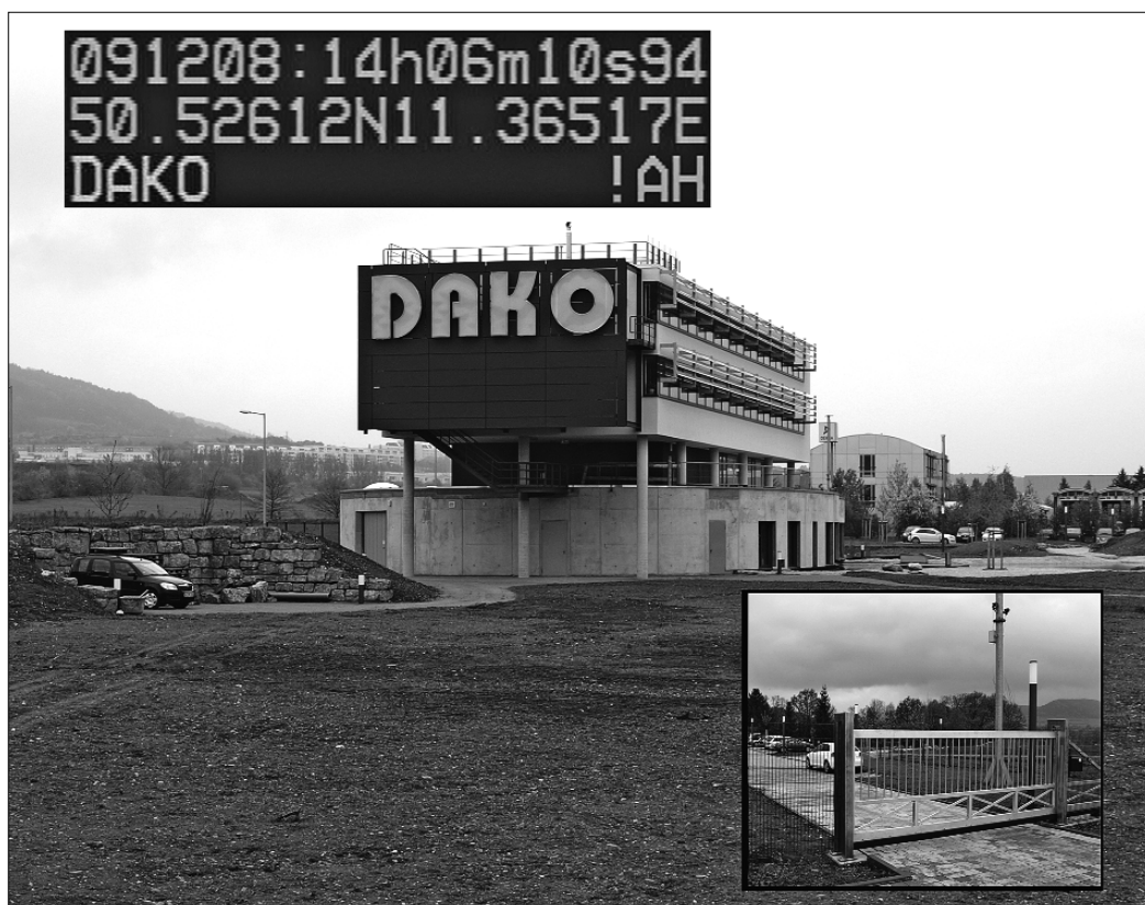
Überwachung mit Timer2 LAN mit Firmengelände (Hauptbild) und Haupttor mit Überwachungskameramast (PIP-Bild).
